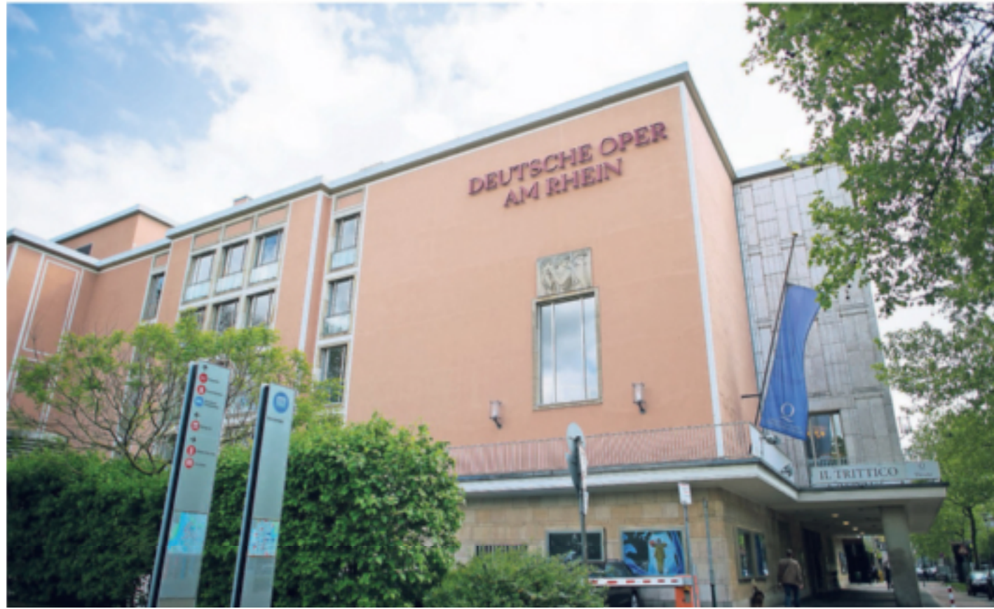
Eine Sanierung des Rheinoper-Nachkriegsbaus aus den 50er Jahren in der Düsseldorfer Innenstadt dürfte nach Schätzung von Fachleuten mehr als 100 Millionen Euro kosten. FOTO: DPA
